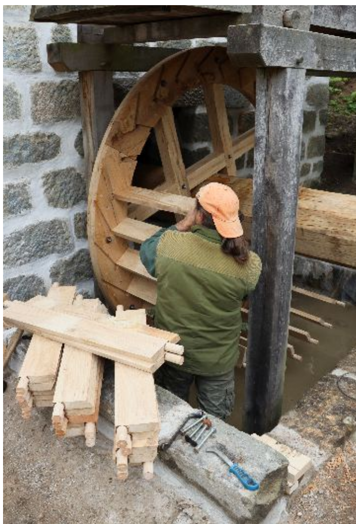
Výměna vodního kola na Veselém kopci
