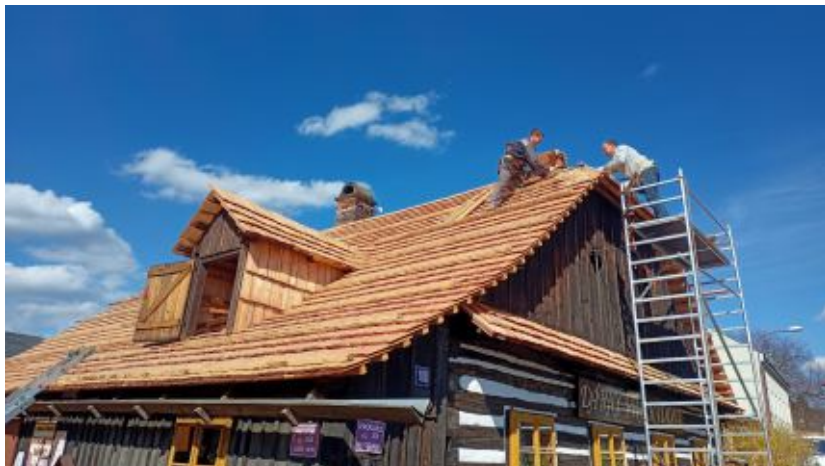
■ Výměna střešní krytiny na jednom z objektů v areálu Betlém
