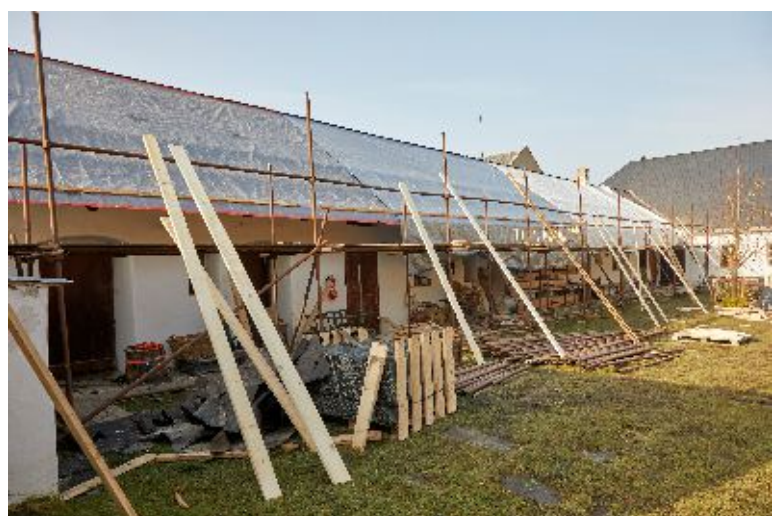
Výměna střešní krytiny na Kameníčkově gruntu v HMP
