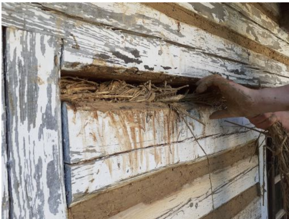
Oprava hliněných vymazávek
