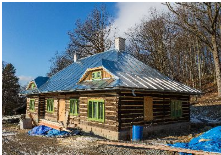
Stavba hájovny – jednoho z prvních objektů nového areálu Kolibiska
