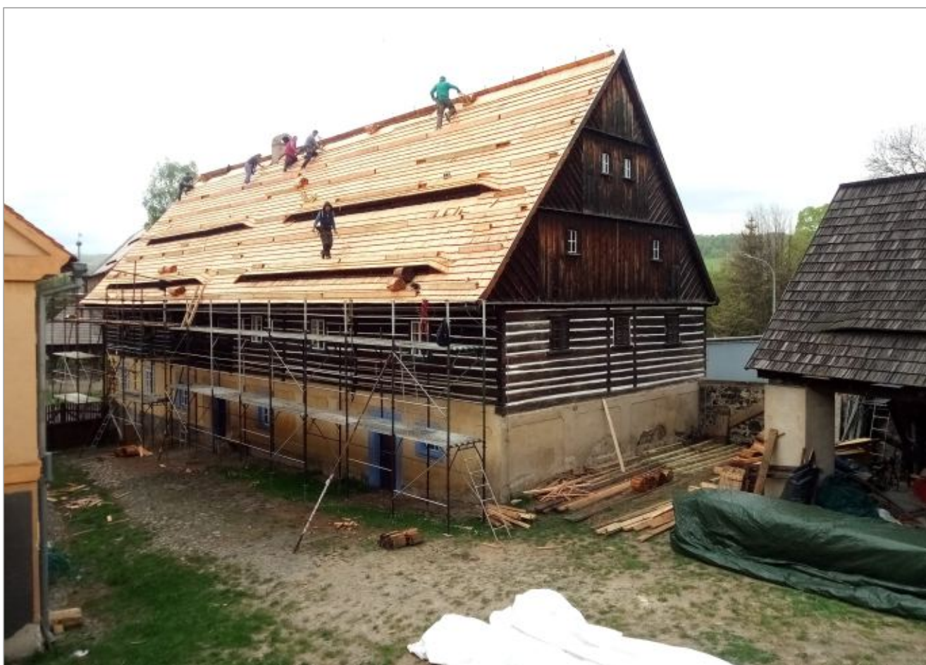
Oprava střechy v MPZ
