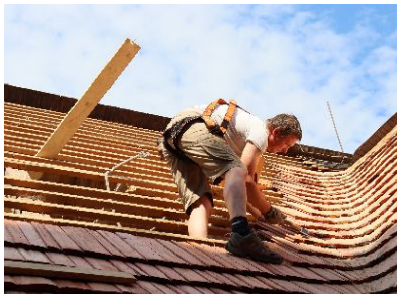
Výměna střešní krytiny v MPV
