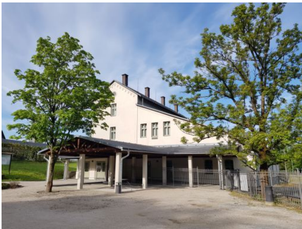
Nový přístřešek u Sušáku
